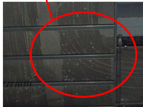
ケーブルラック底面に付着した産毛
