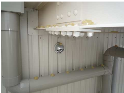
P E Tカップを使用した設置方法
